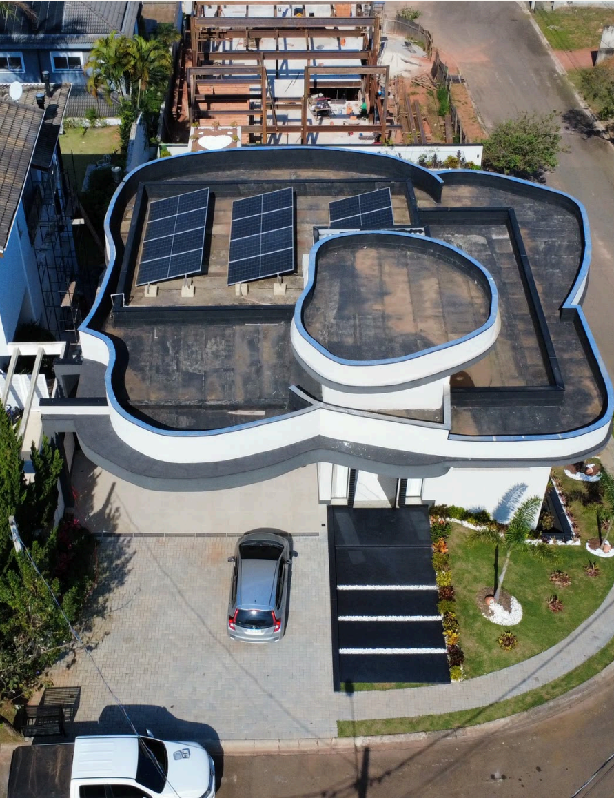
Cobertura com placas de energia solar
